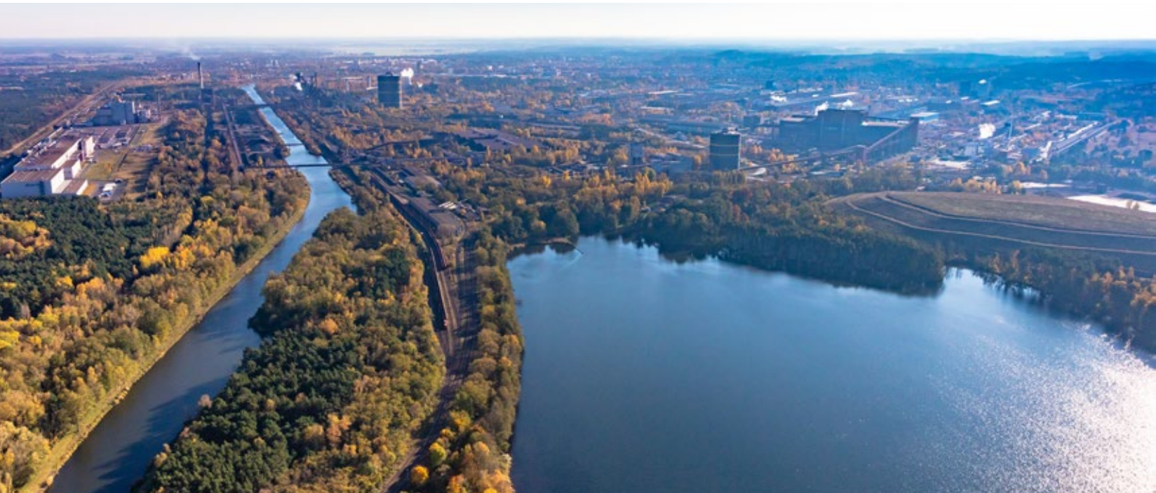
Das Eisenhüttenkombinat Ost entstand Anfang der 1950er-Jahre an der deutsch-polnischen Grenze. Heute arbeiten bei ArcelorMittal Eisenhüttenstadt etwa 2.700 Menschen. Foto: Bernd Geller
